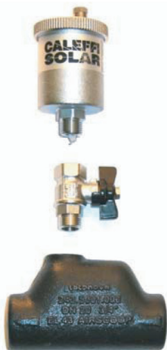
Obr. 32: Vodorovný separátor vzduchu a automatický odvzdušňovací ventil
