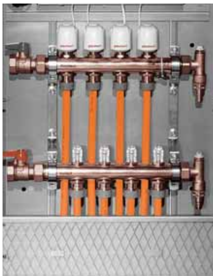
5. Detail připojení trubek k rozdělovací stanici
