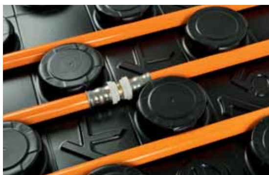
5c. Lisovaný spoj v konstrukci podlahy
