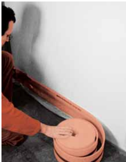
1. Položení dilatačních pásů
