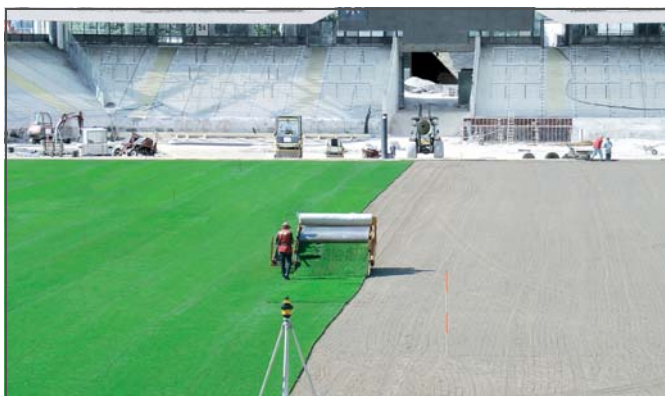
Obr. 9-34 Pokládka travního koberce
