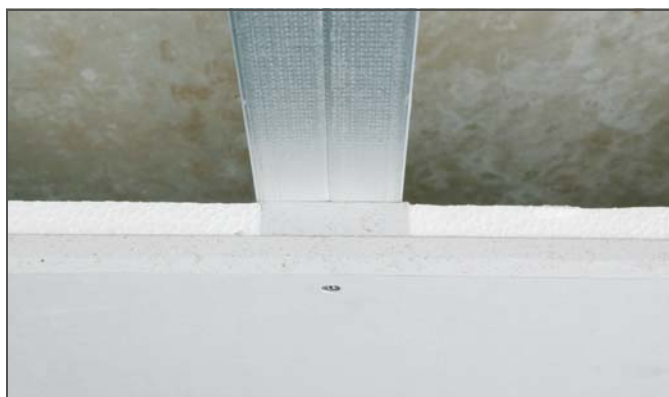
Obr. 4-6 Upevnění stropních desek
