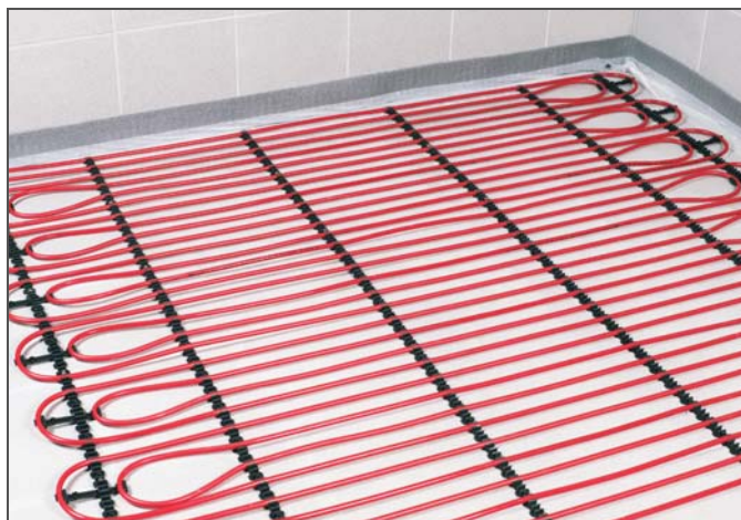
Obr. 3-67 Systém REHAU vodící lišta 10 - mokrý způsob
