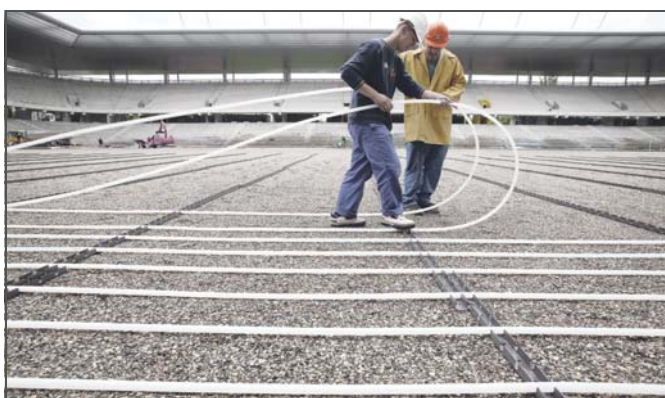
Obr. 9-33 Pokládka topných trubek
