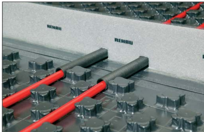
Obr. 5-3 Dilatační profil REHAU na systémové desce Varionova
