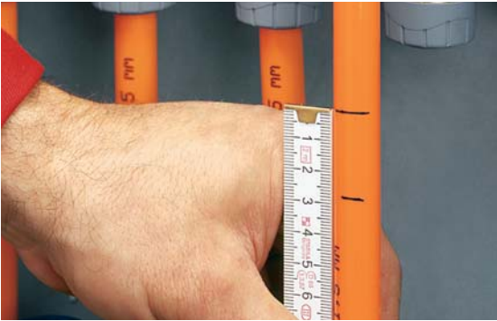
6a. Označení hloubky zasunutí 27 mm
