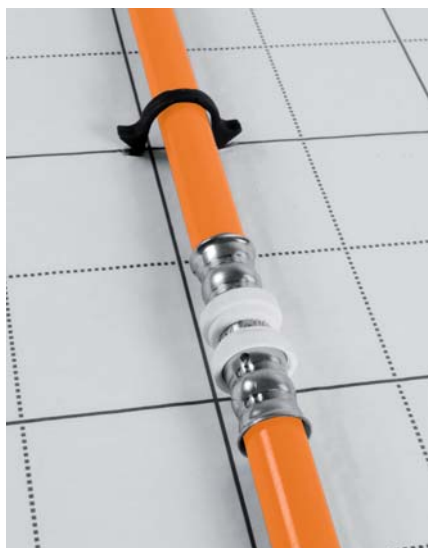
4. Detail uložení trubek na systémovém pásu
