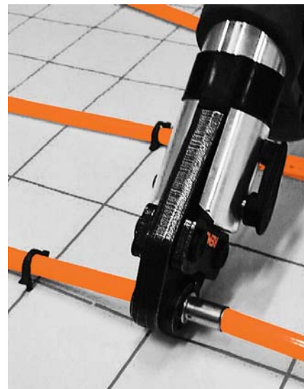
3. Spojení trubek lisovaným spojem
