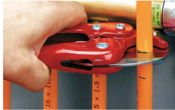
6b. Úprava délky trubky na horní značce
