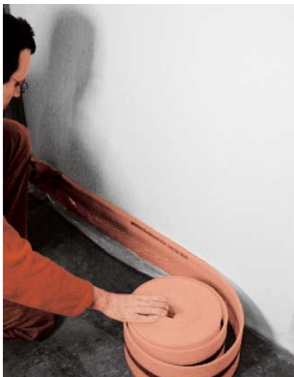
1. Položení dilatačních pásů
