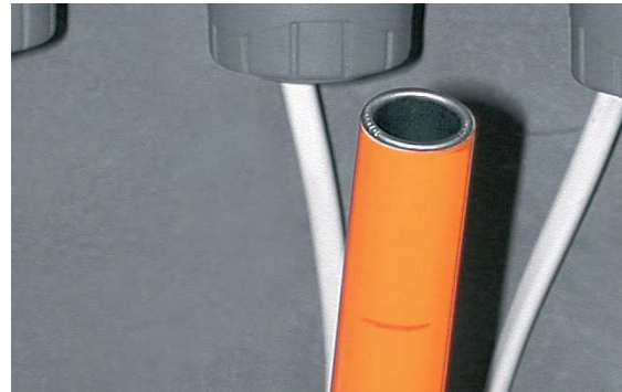
6d. Kontrola usazení opěrného pouzdra
