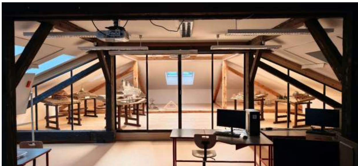
Obr. 8: Rekonstrukce a zateplení podkroví.
