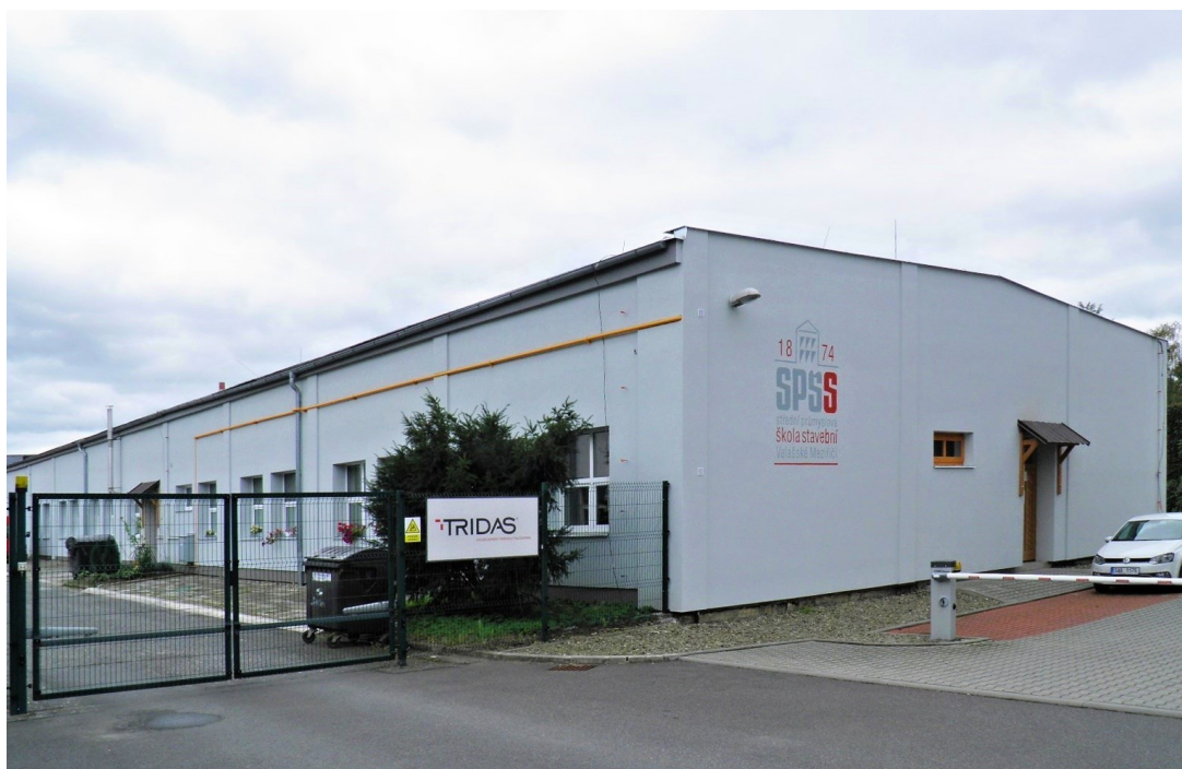
Obr. 2: Oprava dílen truhlářů a tesařů na Vrbenské ulici.
