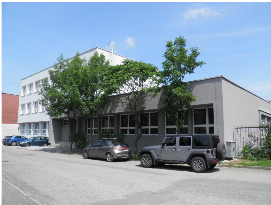
Obr. 9–10: Zateplení správní budovy Vrbenská
